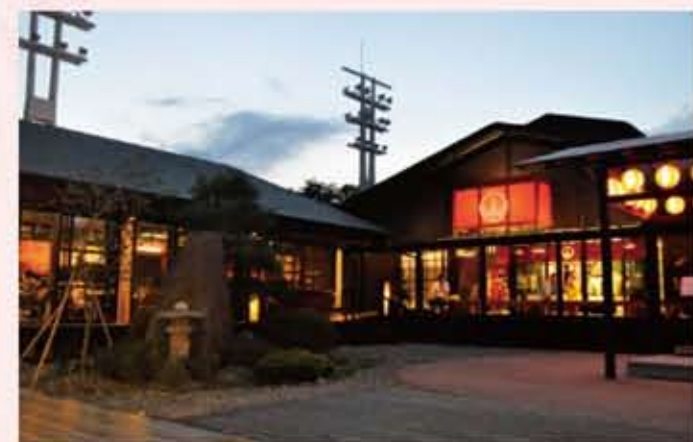
左は清涼館、右は芦の湯浴棟
